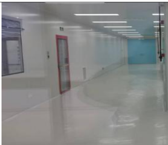
项目空厂房照片
