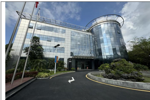
西北面：A1 栋产业促进中心
