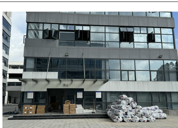
项目所在建筑物（B4 栋厂房）
