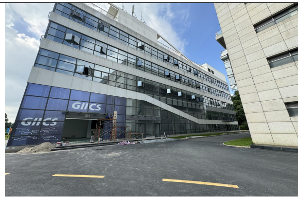
西北面：B1 栋厂房
