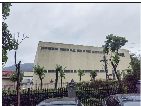
本项目所在建筑物南面：广东嘉博文生物有机肥厂
